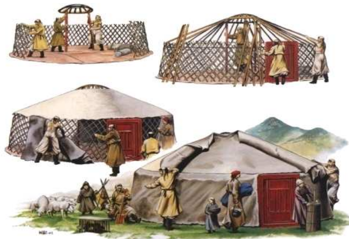
그림 3. 게르를 설치하는 과정 (출처 : 몽골 교육문화 및 과학부)
